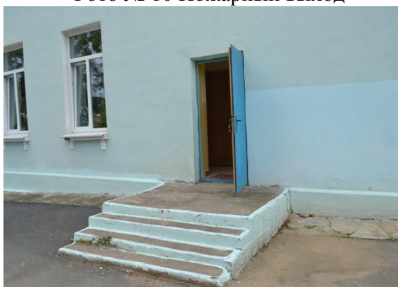
Фото № 10 Пожарный выход
